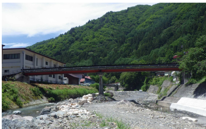
大規模修繕を行う第二前川橋
