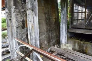
橋脚のひびわれ、遊離石灰
