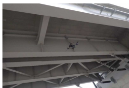
ドローンによる桁下の点検
