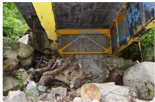
主桁の変形
