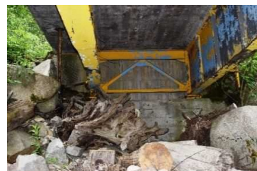
主桁の変形
